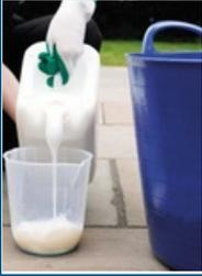
Versez EASIHOLD dans un seau mélangeur avec des pierres dans un rapport de 1:25 en volume. Mélanger jusqu'à ce que tout le matériau soit uniformément couvert.
