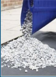
Versez le matériel mélangé dans la zone souhaitée. Assurez-vous que la zone est perméable pour un drainage complet.
