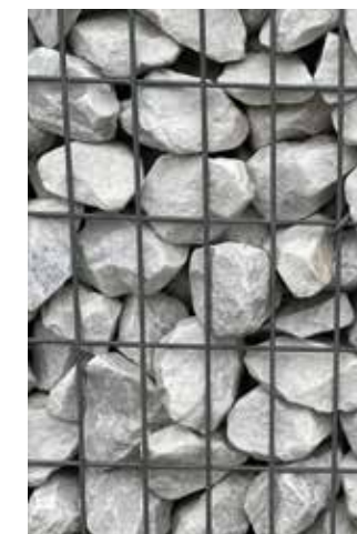
Roche en gabion
